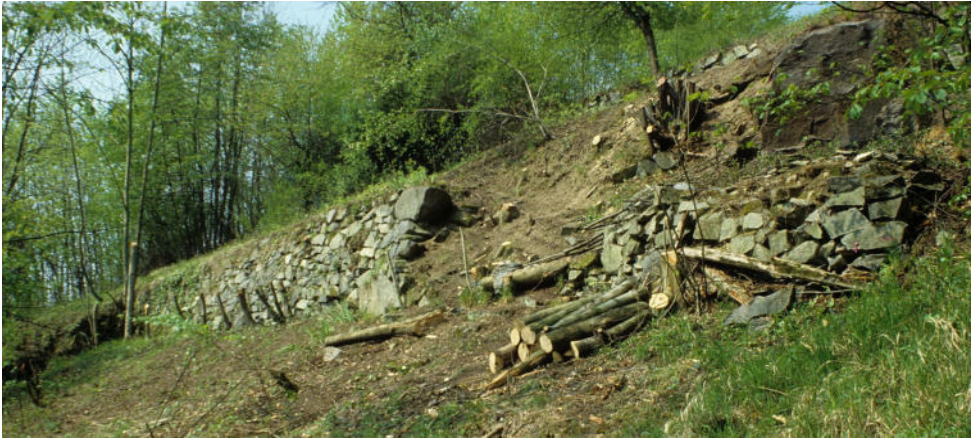
Alte Trockenmauer am Mühlberg wird frei gelegt
