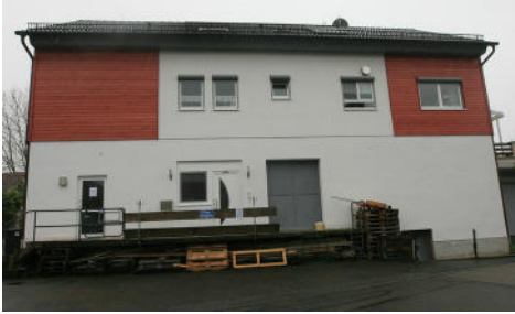
Unsere erste Halle in Gronau wurde später zum Wohnhaus umgebaut (von 1987 bis 1993)
